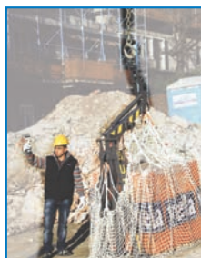
Inserire gli occhielli negli appositi ganci di sicurezza Insert the eyelets in the appropriate safety hooks
