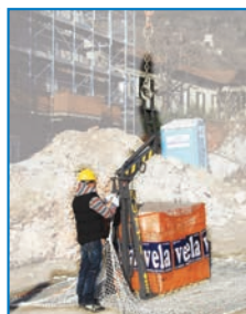
Posizionare il carico sopra la rete senza appoggiarlo Place the load on the net without leaning it against
